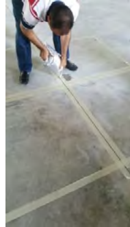
POUR INTO THE JOINT
